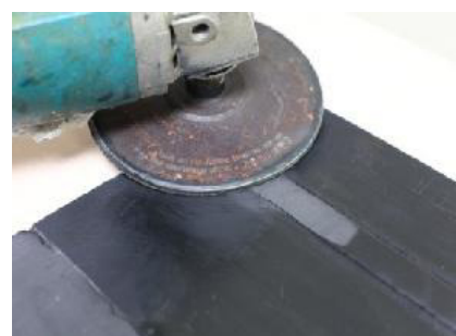
Polir a superfície de reparação após 30 minutos.
