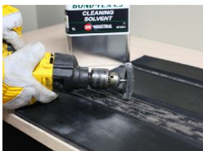
Polir a superfície de reparação.
