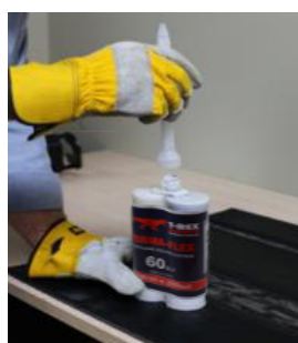
Enroscar o misturador estático.
