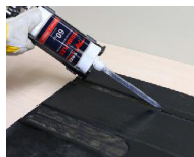
Нанесите восстанавливающее покрытие «Перма-Флекс».
