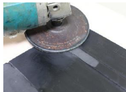
Отшлифуйте участок нанесения через 30 минут.
