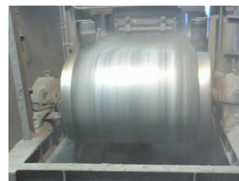
Efter installation av Tru-Trac
