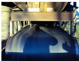
Efter installation av Tru-Trac
